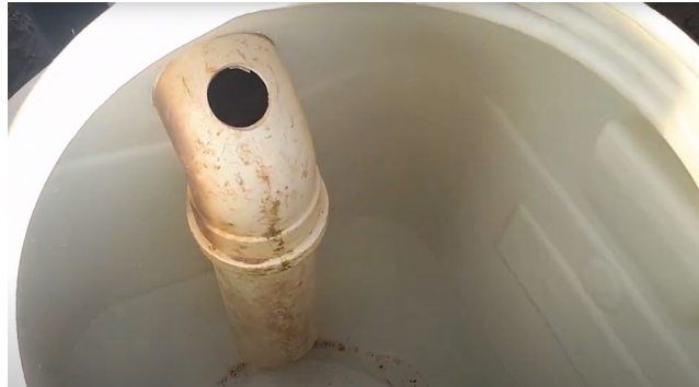
Figura 3- Suspiro, um orifício circular de 2,5 cm no topo do cano de saída da bombona, para garantir o fluxo de água no sistema em caso de entupimento do elemento filtrante
